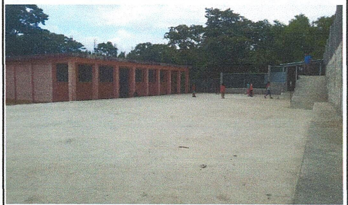
Foto 2: Vista general del patio lado norte del centro educativo donde se realizó el mejoramiento de losa de patio.
